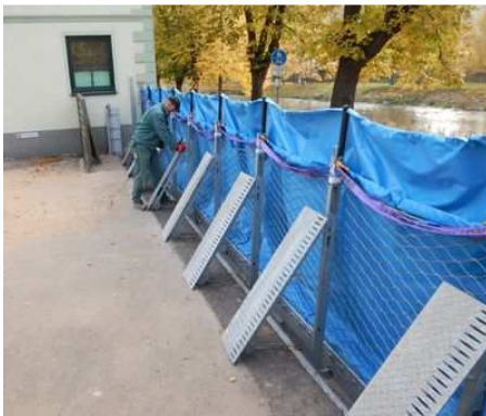
Bilder: Fertig aufgebaut
